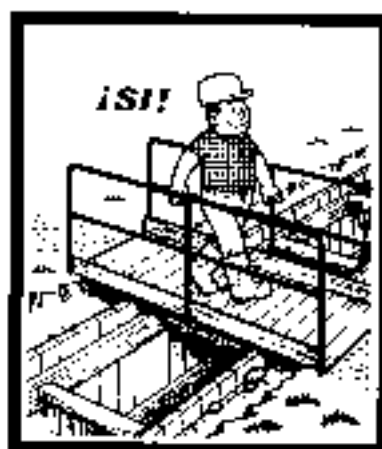
Se deben instalar panderas provistas de barandillas para tutear las zanjas.
