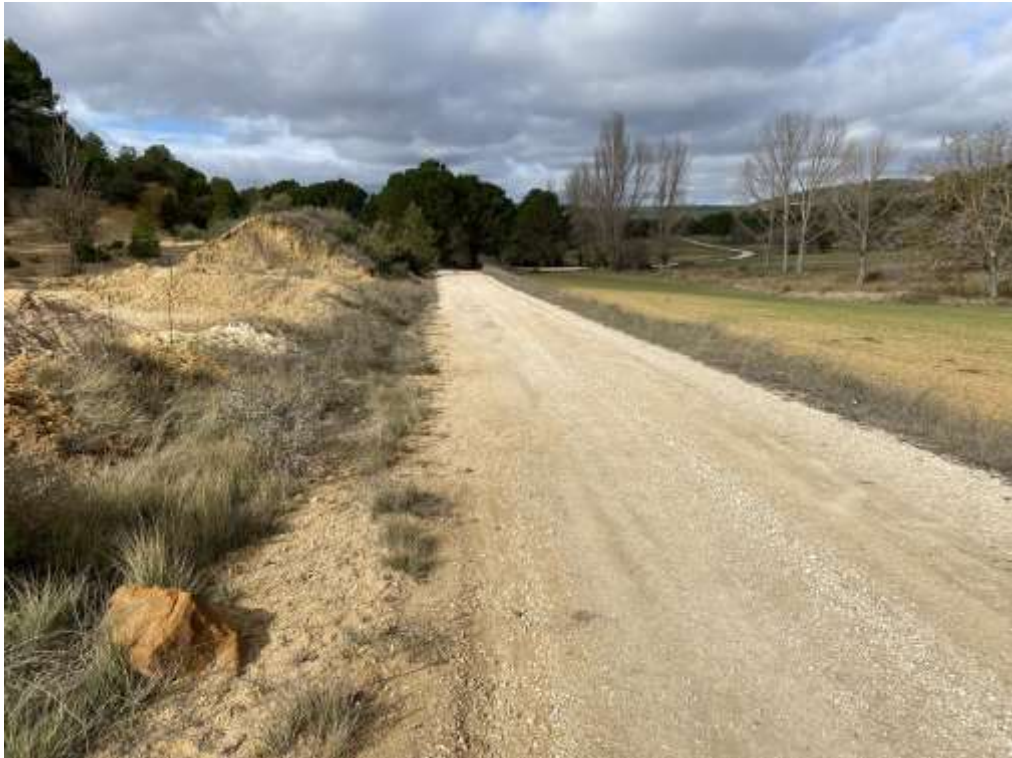
Imagen 30 Fotografía nº 5 Situación del camino colindante a la parcela nº 89
