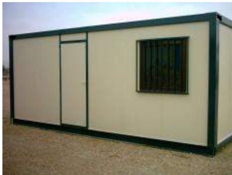
Imagen 15: Caseta provisional de Obra
