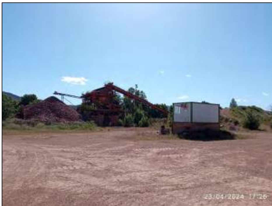
Imagen 10. Maquinaria y caseta de la planta de clasificación de áridos.
