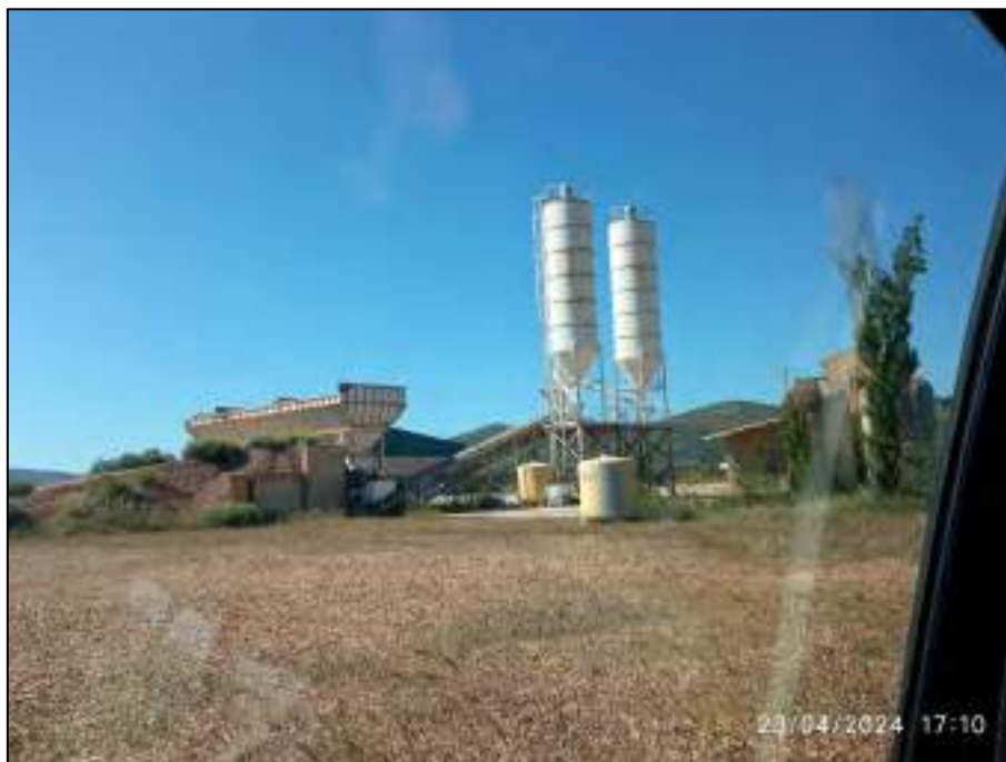
Imagen 8. Tolvas y silos de la planta de clasificación de áridos.
