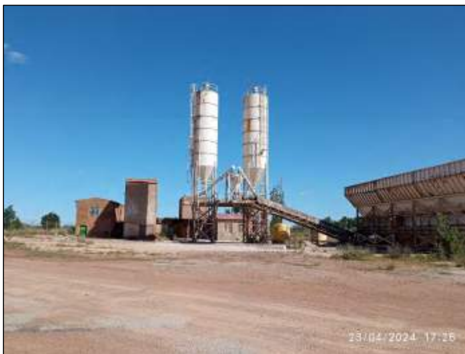
Imagen 11. Edificaciones de la planta de clasificación de áridos.
