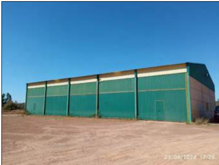
Imagen 7. Nave industrial de la planta de clasificación de áridos.
