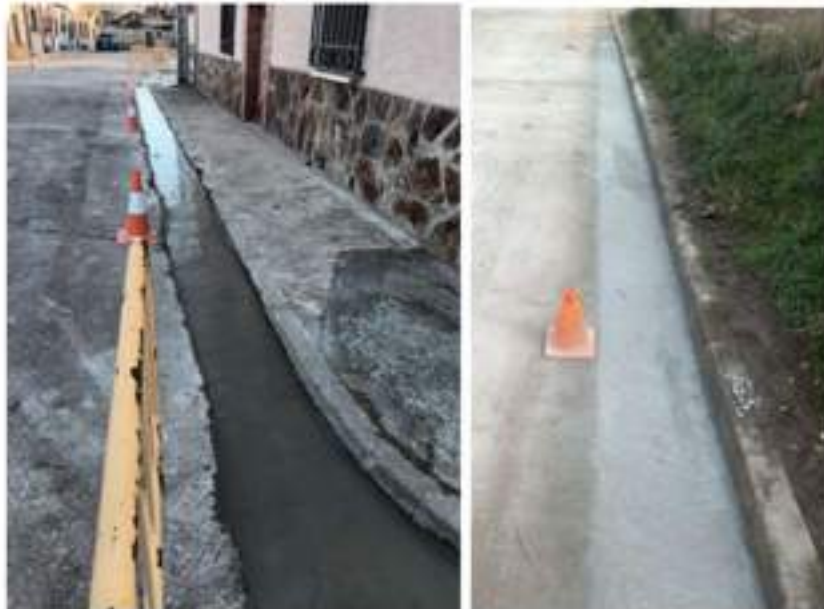
Medidas de seguridad adoptadas para la protección de la canalización.
