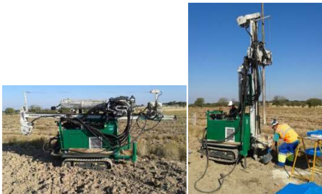
Figura 3. Perforación de un sondeo en la concesión de explotación 'San Miguel' nº 1.962-10, Provincia de Zamora. Se han propuesto 14 sondeos a rotación con extracción continua de testigo, la ubicación de los cuales se muestra en la Tabla 4.
