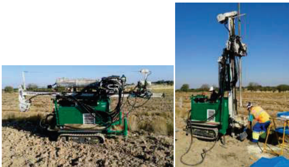
Figura 3. Perforación de un sondeo en la concesión de explotación 'San Miguel' nº 1.962-10, Provincia de Zamora
