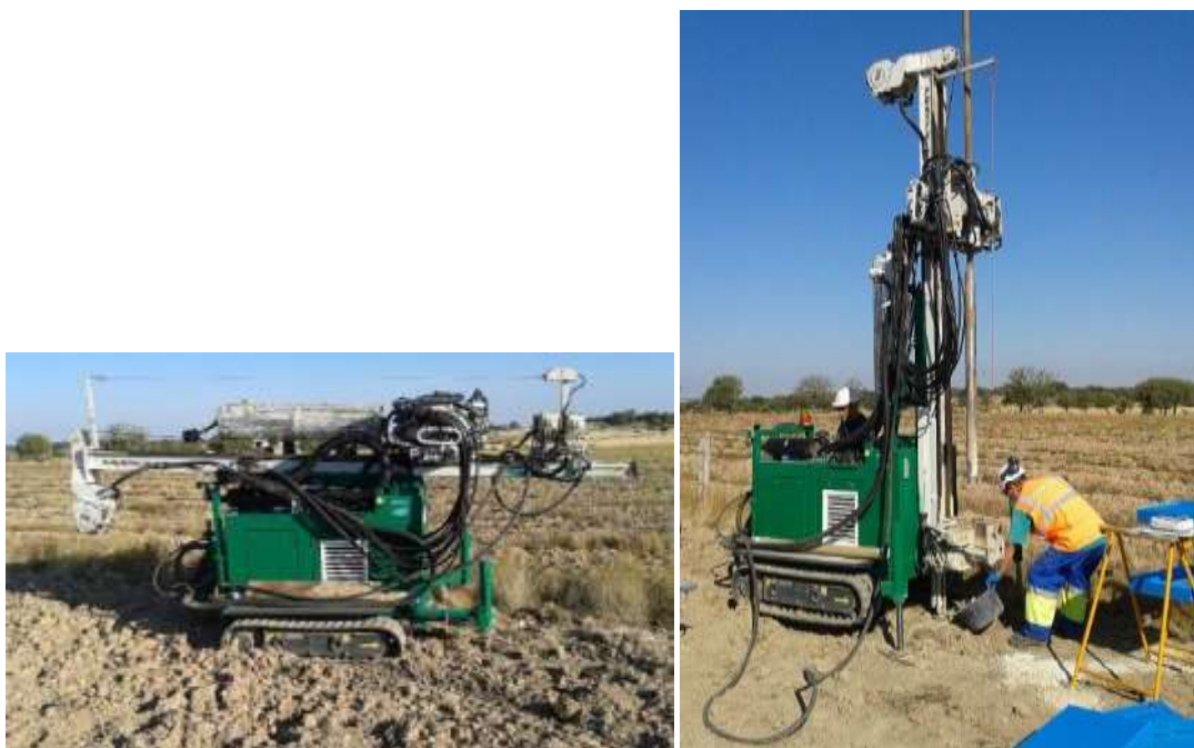
Figura 3. Perforación de un sondeo en la concesión de explotación 'San Miguel' nº 1.962-10, Provincia de Zamora
