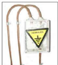
Caja de Seccionamiento de Protección
